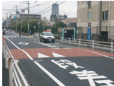
▶ 大和公園南側の段差（ハンプ）
